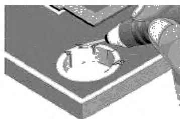
Рисунок 13 а – Удаление поврежденного материала фрезерованием
