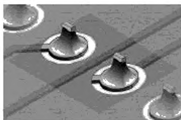
Рисунок 3 с – Удаление покрытия завершено
