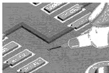
Рисунок 8 б – Введение эпоксидного состава в полость
