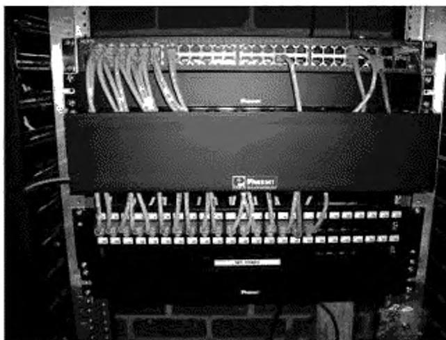
Рисунок 7 – Пример использования окрашенных в разные цвета кабелей
