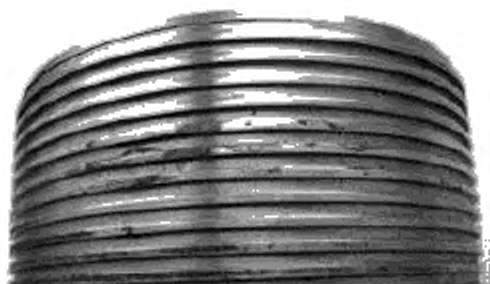
а) Следы коррозии на наружной резьбе
