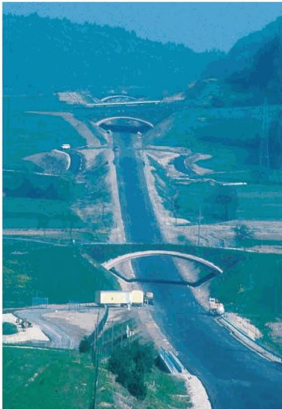
Рисунок 3 – Пример устройства последовательно расположенных надземных переходов
