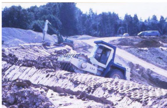
Рисунок 2.2 — Уплотнение глиняного экрана ([26])
