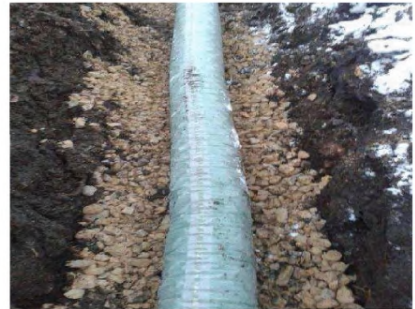
Рис. 2.12 — Газосборная траншея с дренажной трубой (Пермский край) ([47])
