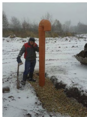
Рис. 2.14 — Газорыпуск при устройстве траншейной системы сбора биогаза (Пермский край) ([46])
