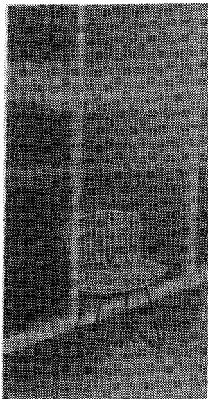
Рис. 3. Перегородка из узорчатого стекла с высоким светорассеиванием
