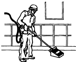
Рис. 15. Удаление с валика излишков раствора
