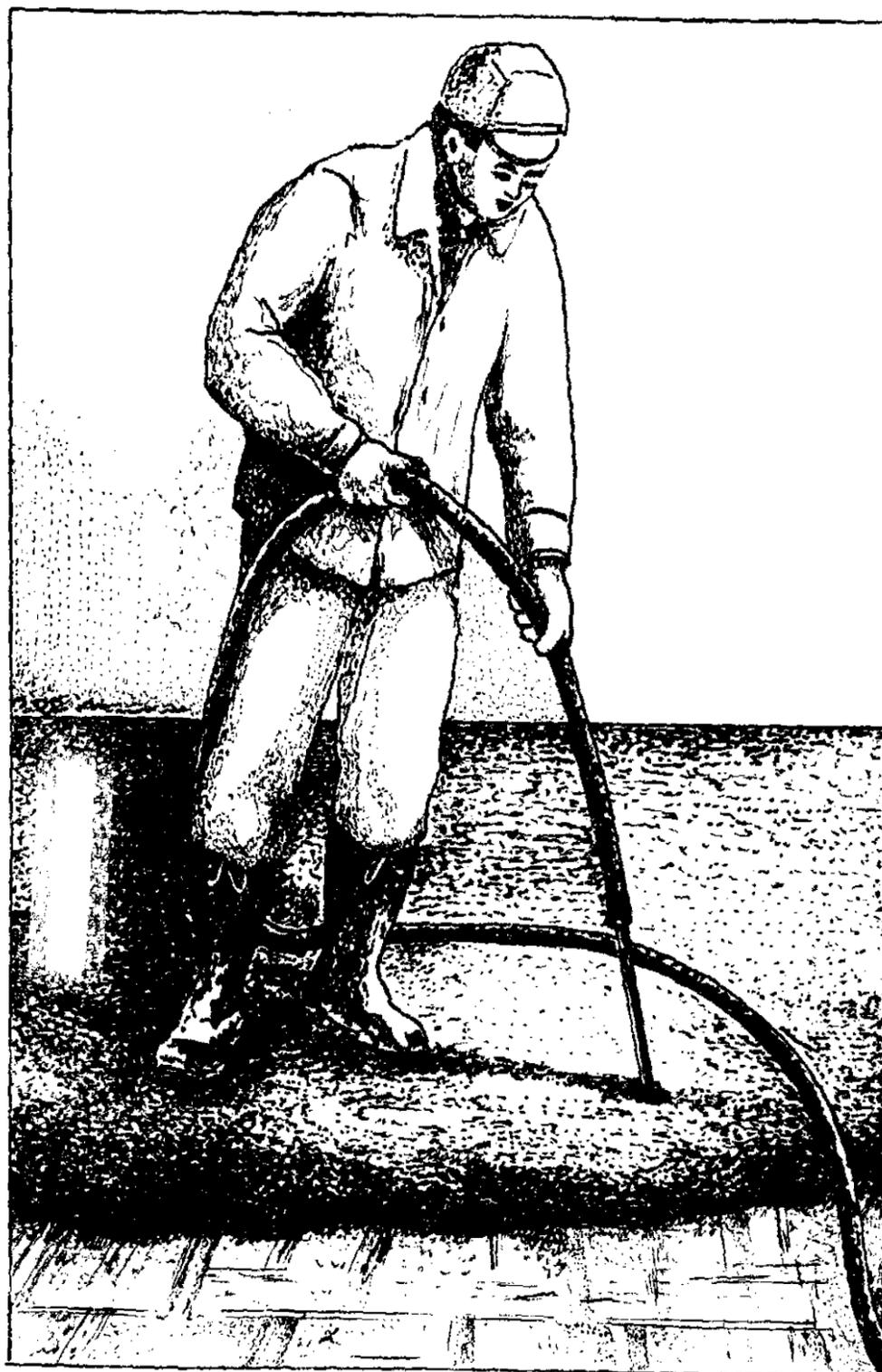
Рис. 1. Заливка самовыравнивающегося раствора
